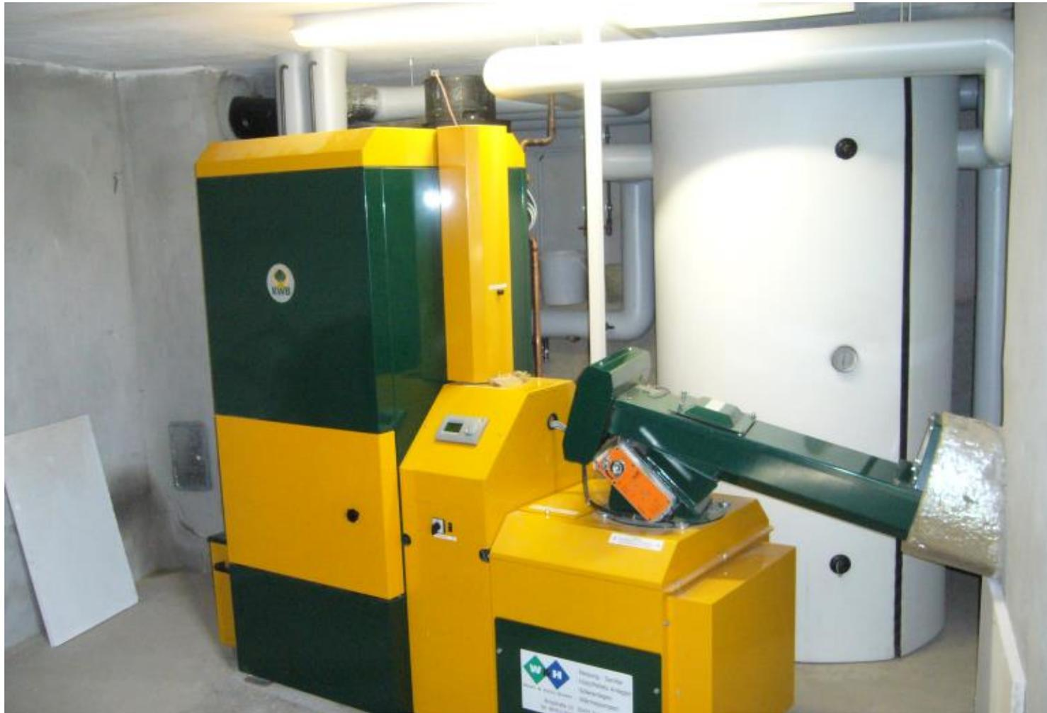
**KWB Biomassekessel mit 101 kW Leistung**
