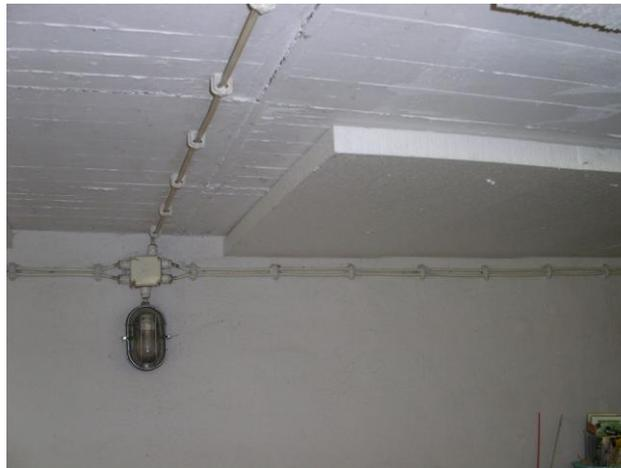
Zehn Zentimeter sollten es bei einem guten Dämmstoff mindestens sein. Das Anbringen in Schichten erleichtert das Einarbeiten von Rohren und Anschlüssen.
