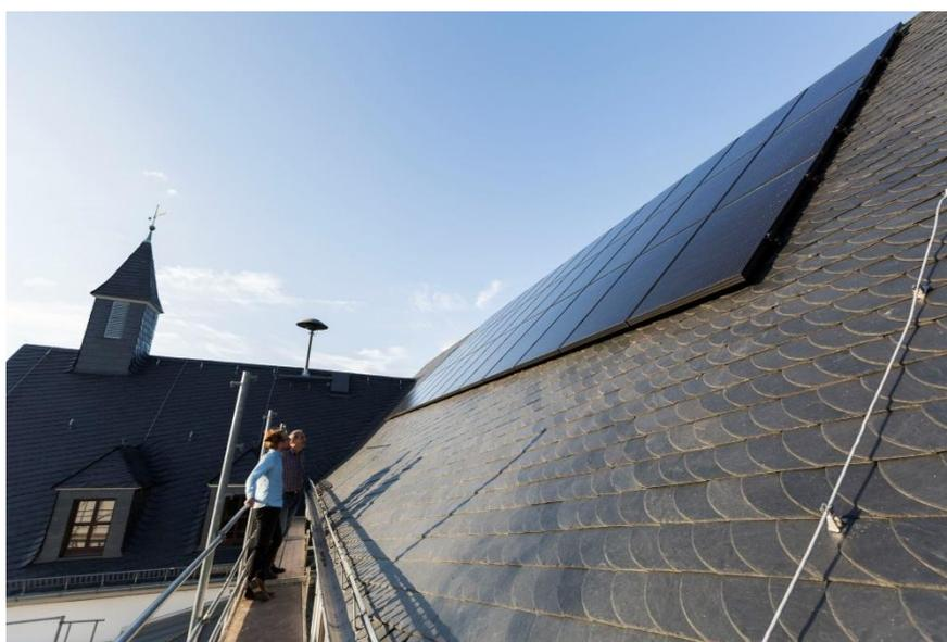
Anfang Mai 2017 wurde auf dem sanierten Gemeindehaus im Ortskern eine in die Schieferdachdeckung gut integrierte Photovoltaik-Anlage mit einem Batteriespeicher zur Speisung der LED-Straßenbeleuchtung im kompletten Ort installiert.
