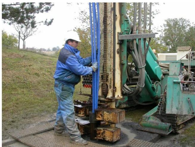
Erdreich oder Grundwasser sind als Wärmequelle für Wärmepumpen die erste Wahl. Dafür sind Bohrungen erforderlich, die bis zu 100 Meter in die Tiefe reichen können.
